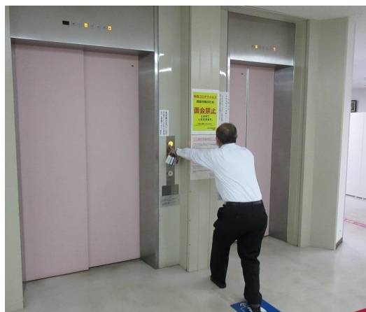
火災によるエレベーター内での閉じこめを防ぐために、 両方のボタンを押して動かないようにしています。
